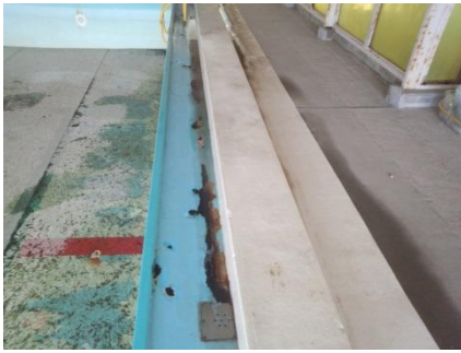
〈錆の腐食で危険になった〉
