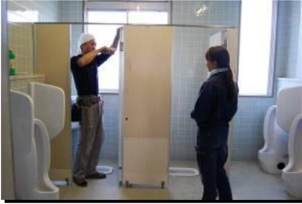
トイレパーテーション取り付け部の増し締めや、ボルト修繕、ドアの取り付け部の修繕を慣れた手つきで、学校内全箇所実施。
