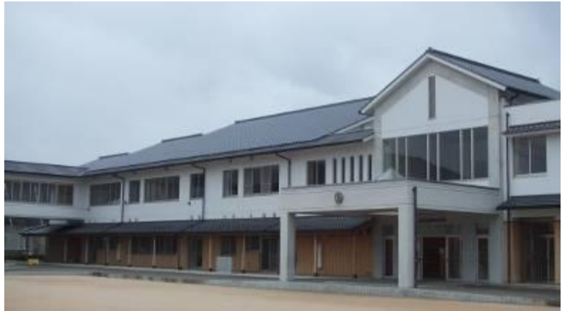
運動場側から見た校舎
